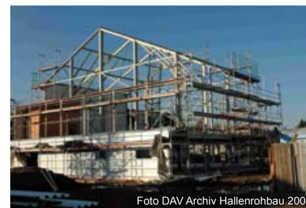
Foto DAV Archiv Hallenrohbau 2004
