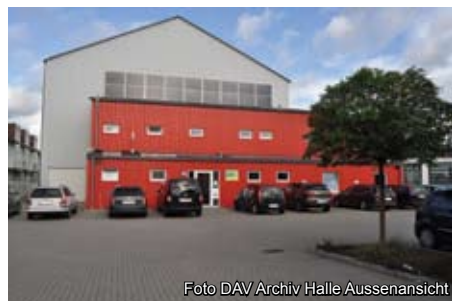
Foto DAV Archiv Halle Aussenansicht
